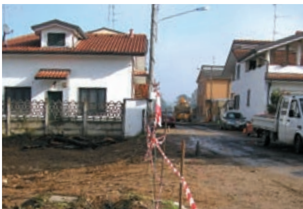
Via S. Giuseppe. Sono in corso i lavori per realizzare fognatura e illuminazione nella via
