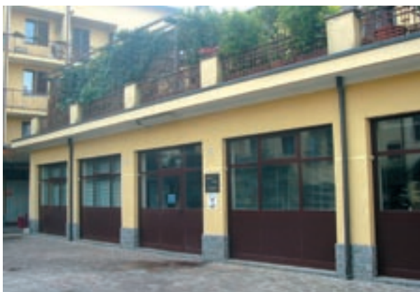
Nuovi serramenti a norma e aperture antipanico per la biblioteca comunale
