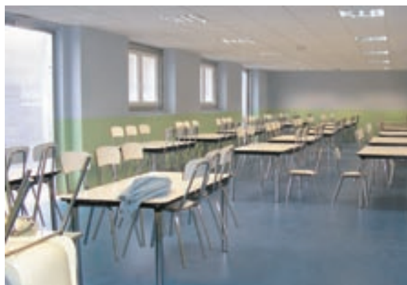
La prima tranche dei lavori alla scuola primaria è stata conclusa. Ecco il refettorio rinnovato, ampliato e risanato
